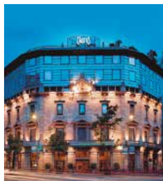
Rénovation d'un hôtel. Le système de récupération de chaleur est idéal pour un hôtel de cette catégorie. Hôtel Claris 5 *. Barcelone, Espagne. ECOi
